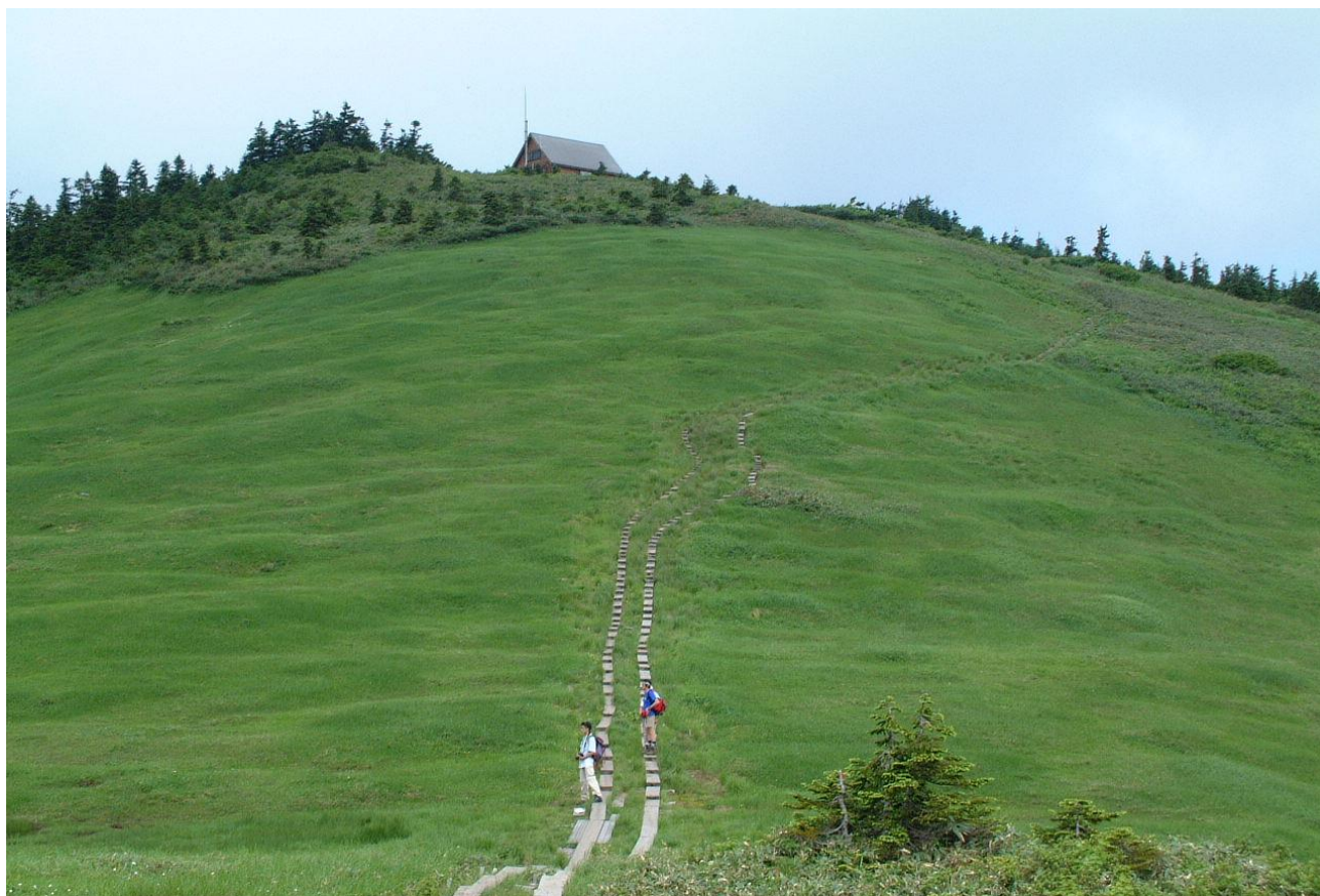
湿原裸地化回復および木道複線化敷設完了（平成 13 年）
