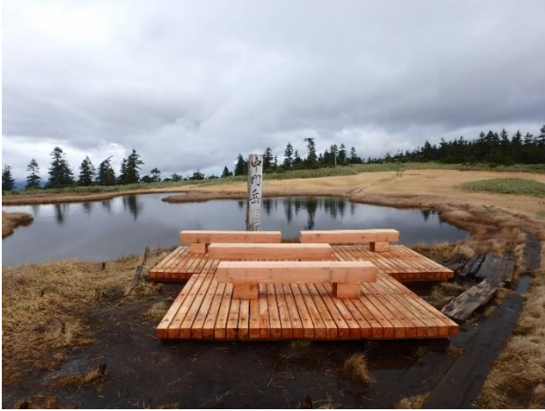
①テラス工事（中門岳、中門大池、駒の稜線）
