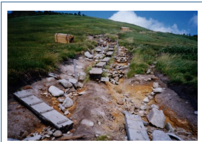
平成5年7月～ 裸地化湿原回復工事
