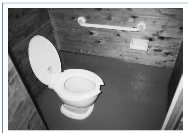
平成14年 公衆トイレ設置（駒の小屋傍）
